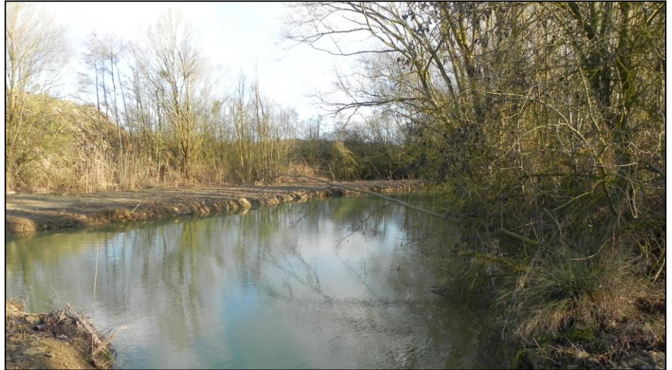
Vue sur le bassin de décantation situé dans la partie Sud du site.
